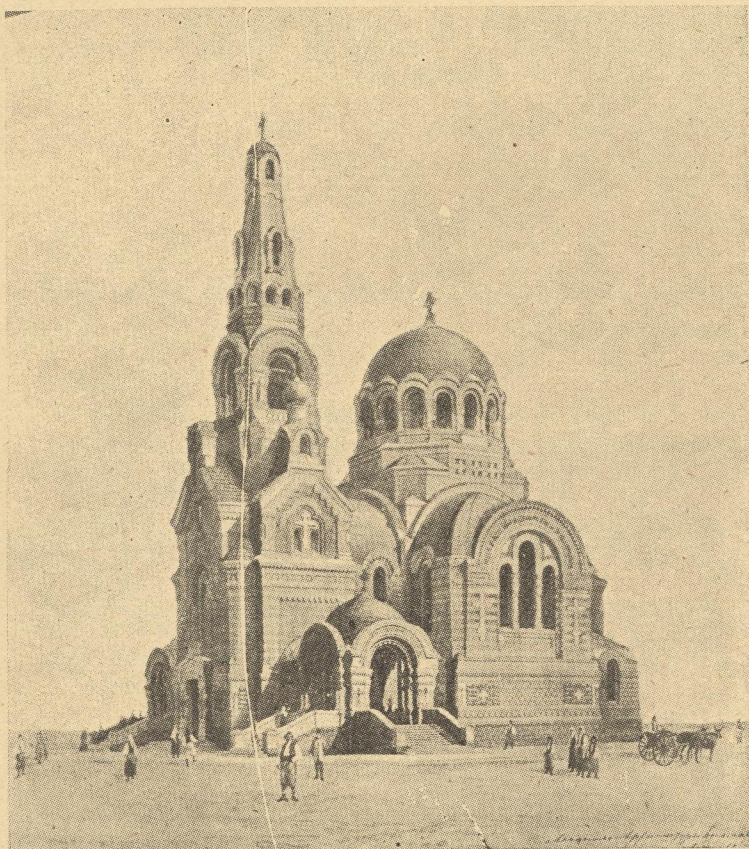
Първиятъ проектъ на храма-паметникъ „Св. Ал. Невски“, направенъ отъ архитекта Ив. С. Богомоловъ
